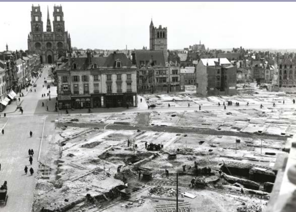
Vue du quartier des Carmes détruit par les bombardements de 1940. Des ouvriers travaillent au déblaiement des décombres. En arrière-plan, la cathédrale et le beffroi. 10 mai 1941 par H. Baranger. ©AMO
