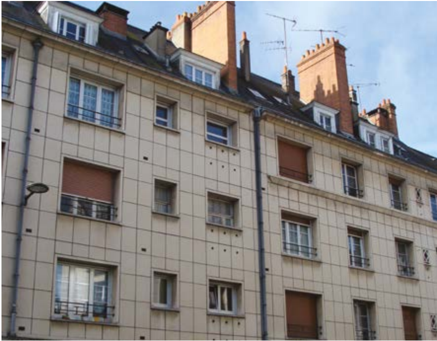
Immeubles de la Reconstruction, îlot 25, 303 - 307 rue de Bourgogne, années 1950.
