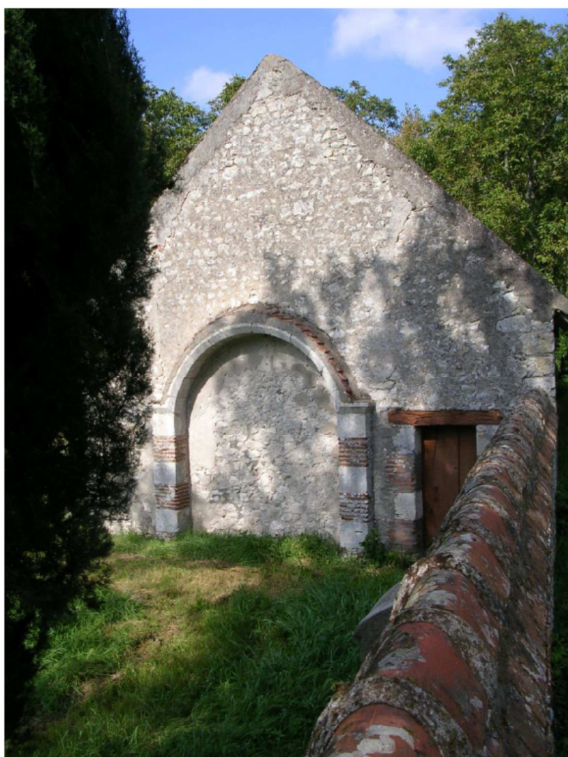
Grange avec arcature extérieure, 2009
