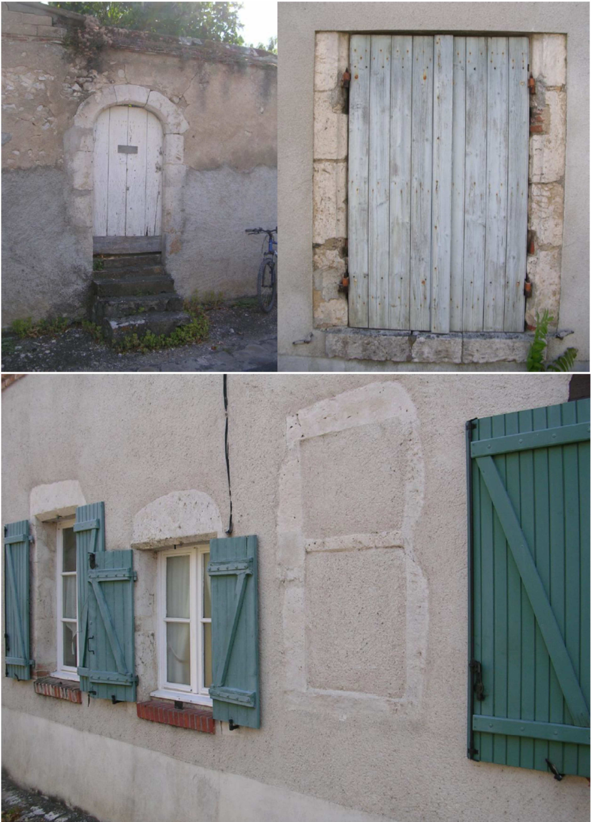
Portes et fenêtres de la rue des Vaslins, 2009
