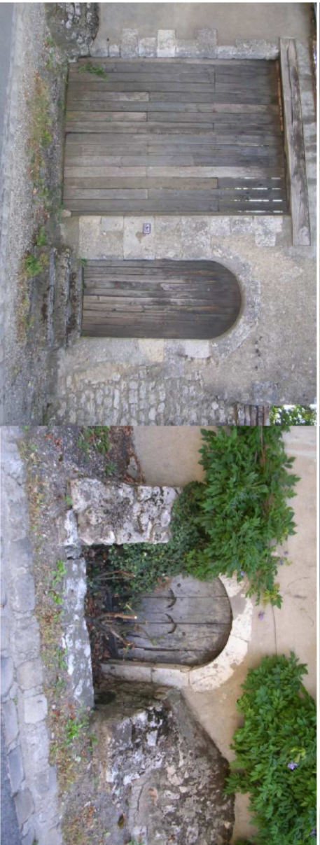
Portes de la rue des Vaslins, 2009
