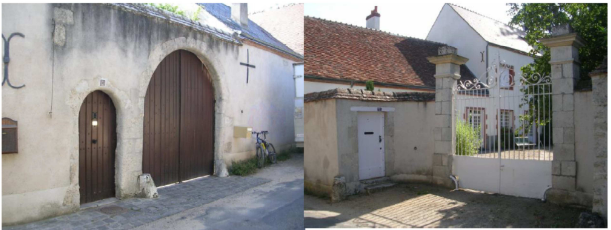
Entrée de propriétés rue du Bouillon, 2009
