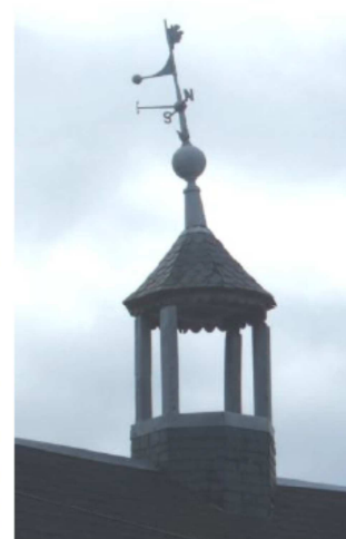
Détail de la toiture (Cliché Ph. Derrien, 2009)
