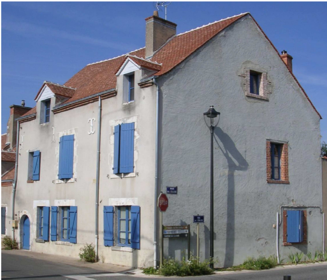
Façade méridionale (Cliché Ph. Derrien, 2009)
