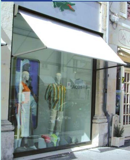
Une devanture dite « en applique » est rapportée en avancée de la façade du bâtiment, et consiste en un habillage, comportant généralement un encadrement et des parties vitrées.
