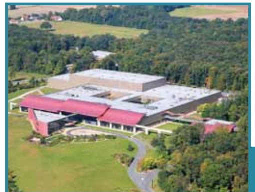
Vue du bâtiment de l'entreprise Shiseido, implantée sur le périmètre de l'agglomération orléanaise. Source : ADEL
